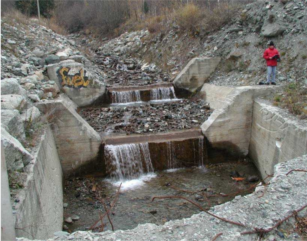
Foto 001 – Opere BATTBR001 e BATTBR002 . Ripresa da valle, dal ponte BATTPO009 sul R. delle Verghe.
