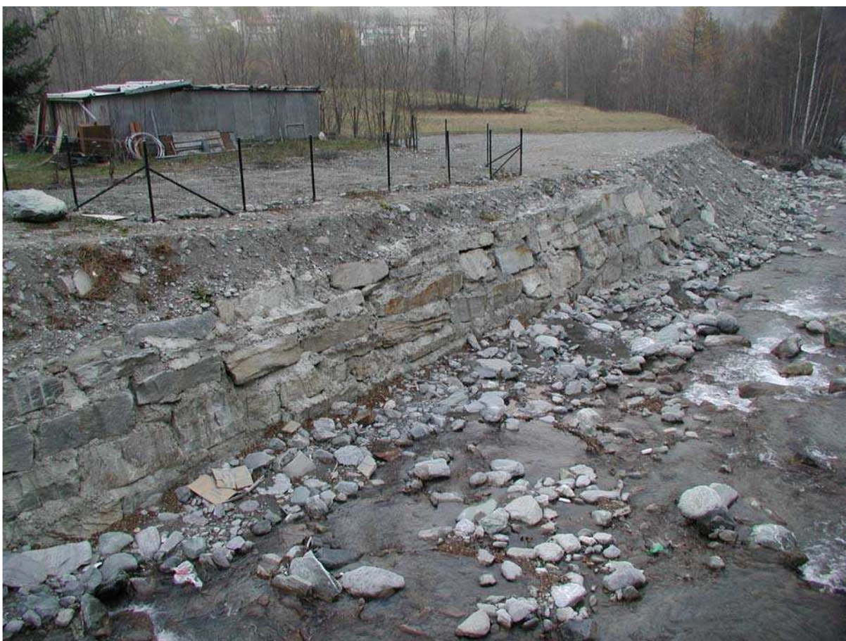
Foto 006 – Opera BELTDS006 . Da monte, in corrispondenza del ponte BELTPO002 sul T. Chisone.
