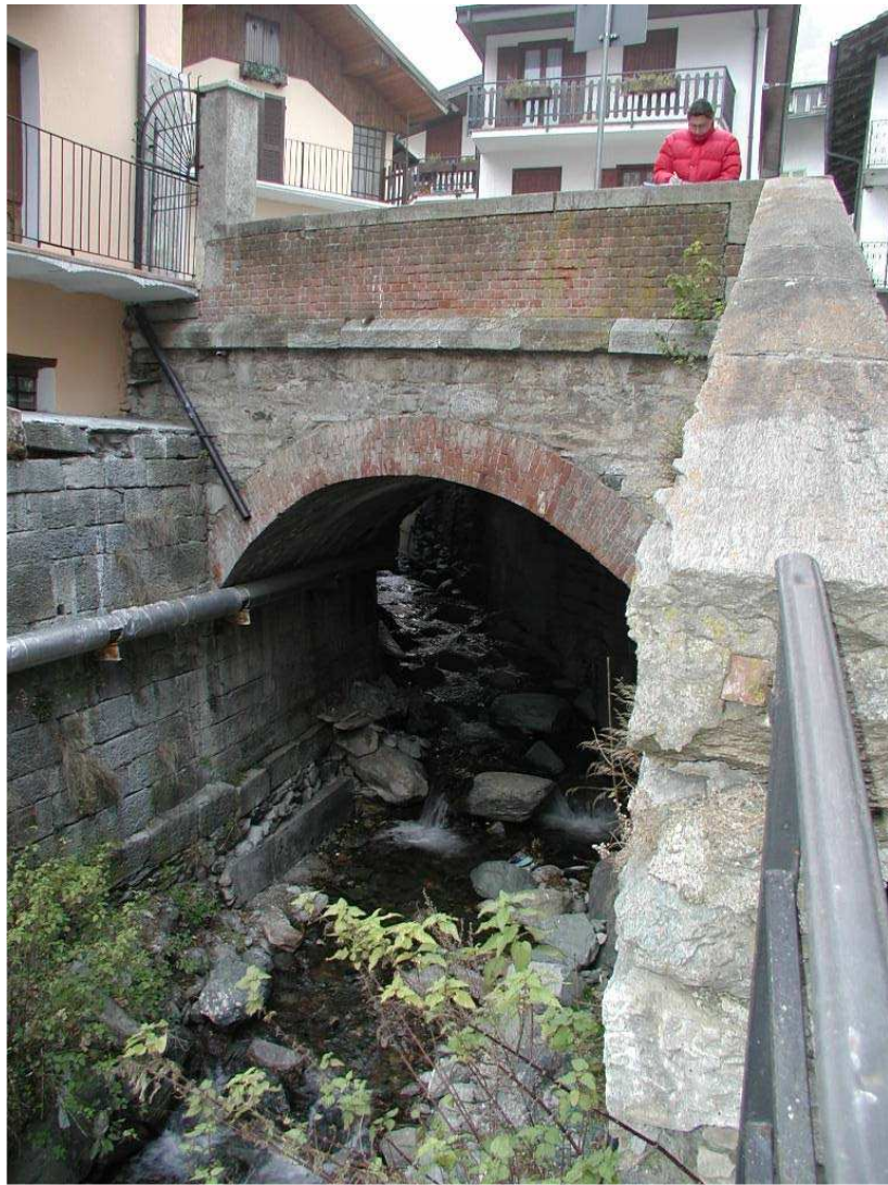
Foto 007 – Opera BATTPO007 . Da valle, sponda sinistra del Rio del Puy.
