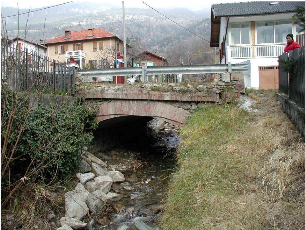
Foto 005 – Opera BATTAG005 . Da valle, sponda sinistra del Rio della Draja.
