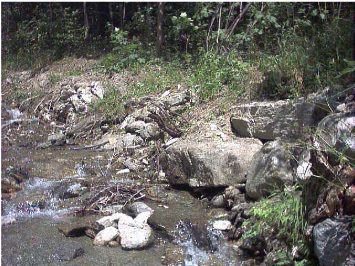
Foto 022 – Opera BELTDS024 . Ripresa da valle, sponda destra del Rio della Draja.
