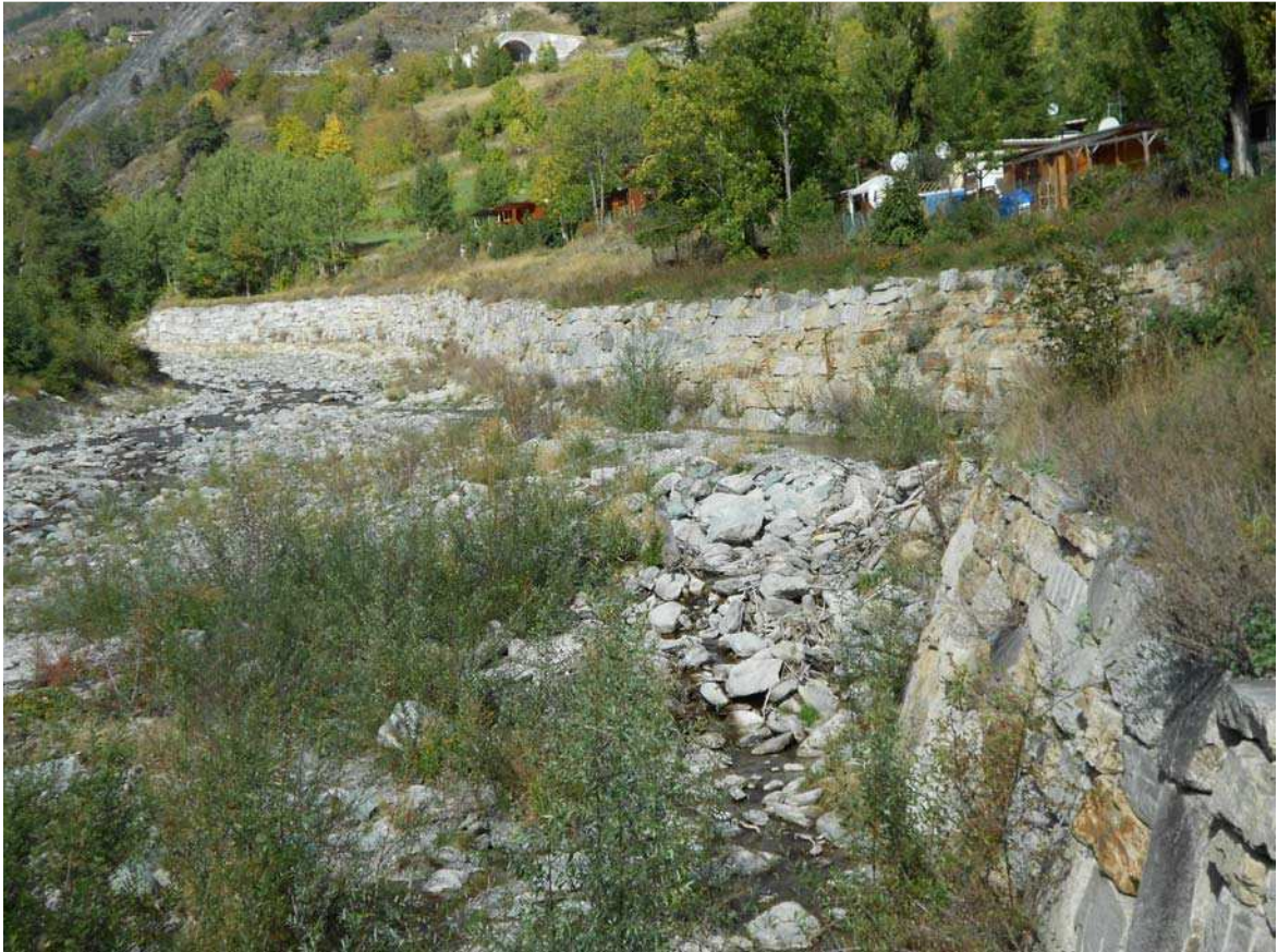
Foto 031 – Opera PAIRDS033 . Da valle, in corrispondenza dell'alveo del T. Chisone.
