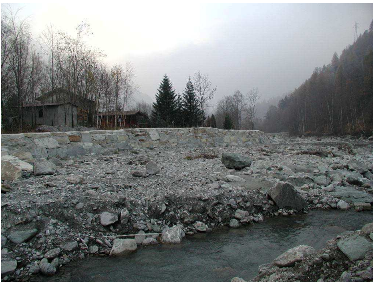
Foto 002 – Opera BELTDS002 . Da monte, in corrispondenza dell'alveo del T. Chisone.
