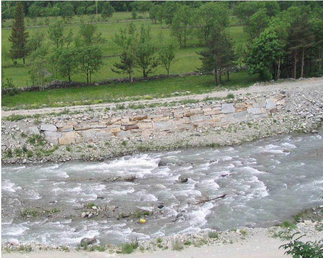
Foto 025 – Opera BATTDS027 . Ripresa frontale, sponda sinistra del T. Chisone. Nota: Sostituita da PAIRDS036
