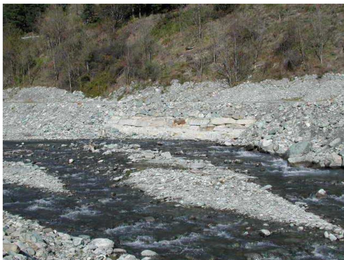
Foto 024 – Opera BATTDS026 . Ripresa da valle, sponda destra del T. Chisone.
