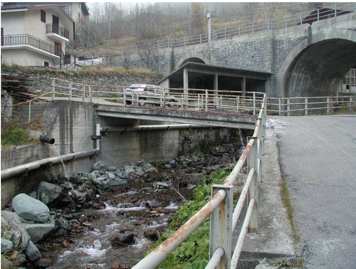
Foto 005 – Opera BATTPO005 . Da valle, sponda sinistra del Rio del Puy.
