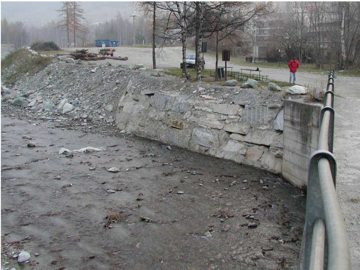
Foto 005 – Opera BATTDS005 . Di fronte, in corrispondenza del ponte BELTPO002 sul T. Chisone.
