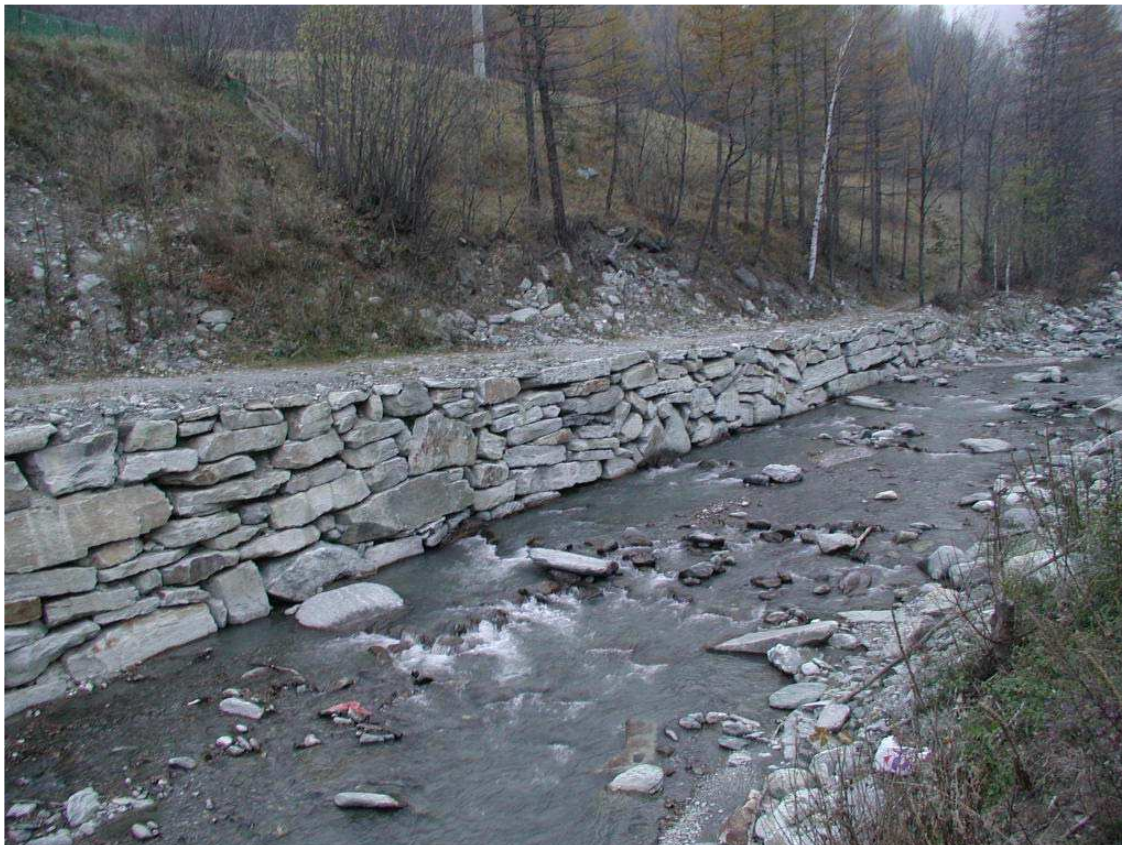
Foto 007 – Opera BATTDS007 . Da valle in corrispondenza del ponte BELTPO008 sul T. Chisone.
