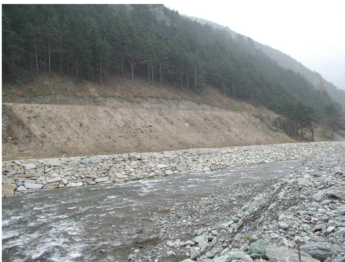
Foto 010 – Opera BELTDS011 . Da sponda destra del T. Chisone, di fronte.
