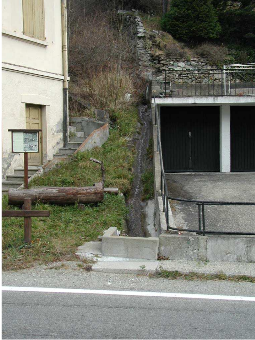
Foto 001 – Opera BATTCA001 . Da valle, di fronte al rio affluente del T. Chisone.
