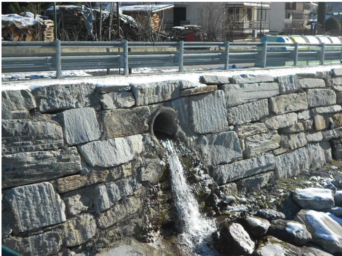
Foto 003 – Opera CASTCA003 . Sbocco della canalizzazione in Chison
