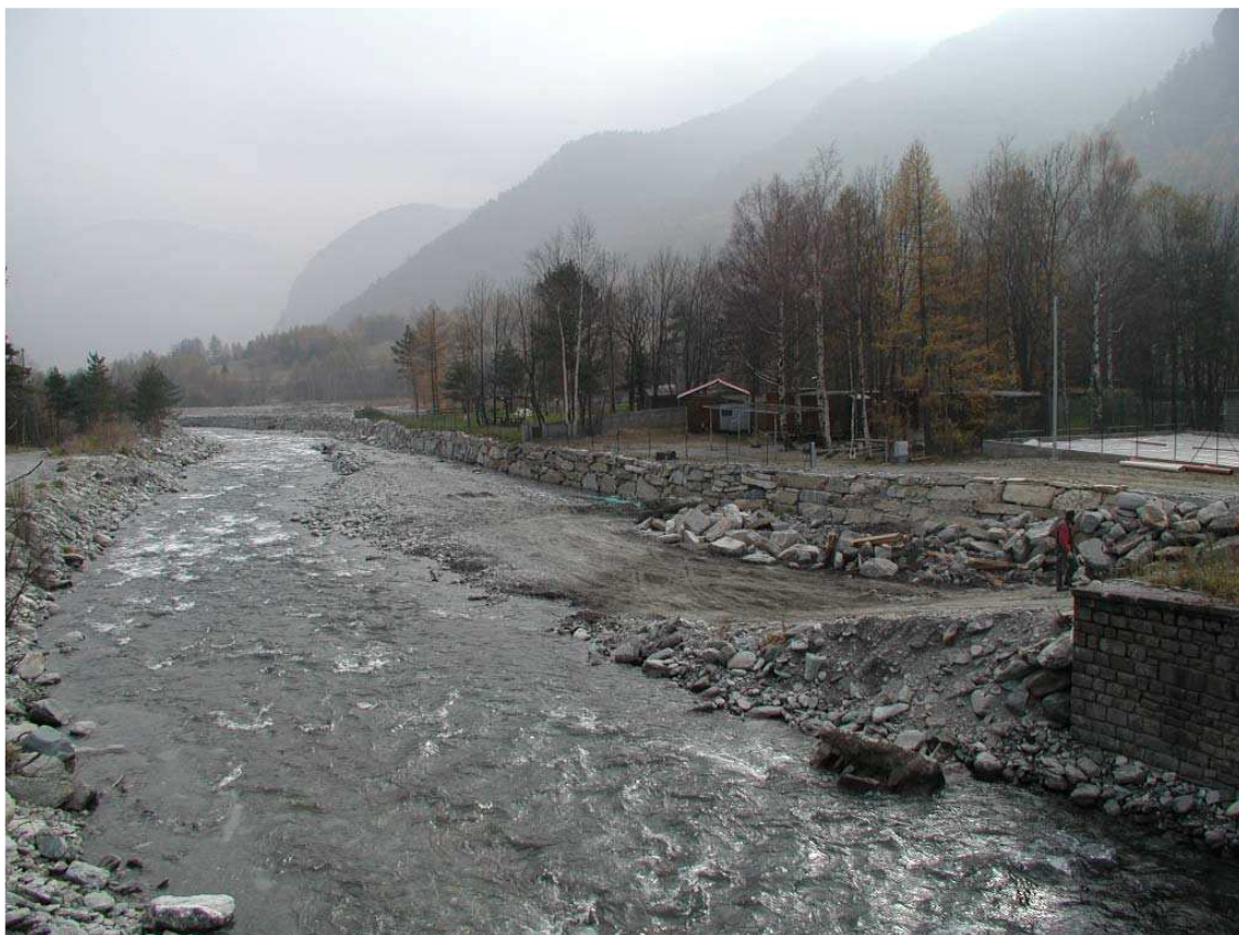
Foto 015 – Opera BELTDS016 . Ripresa da monte, in corrispondenza del ponte BELTPO012.
