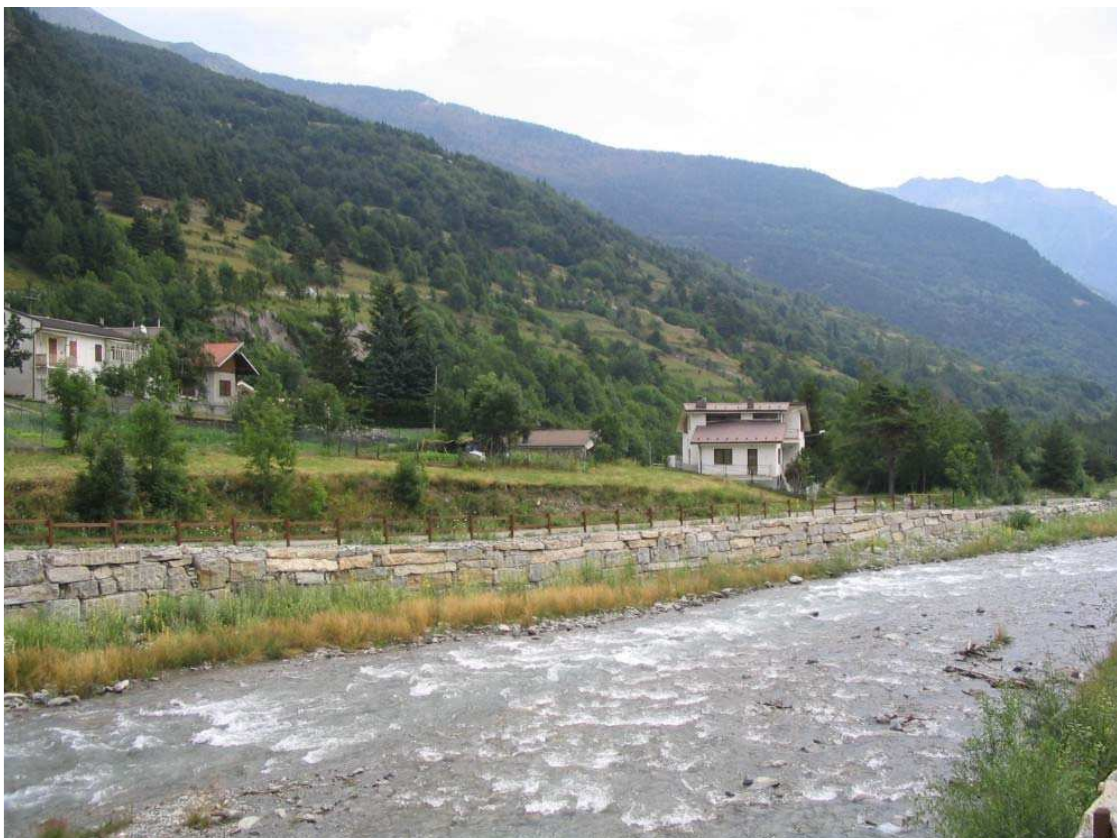
Foto 030 – Opera PENNDS032 . Ripresa da monte, dal ponte BELTPO012.
