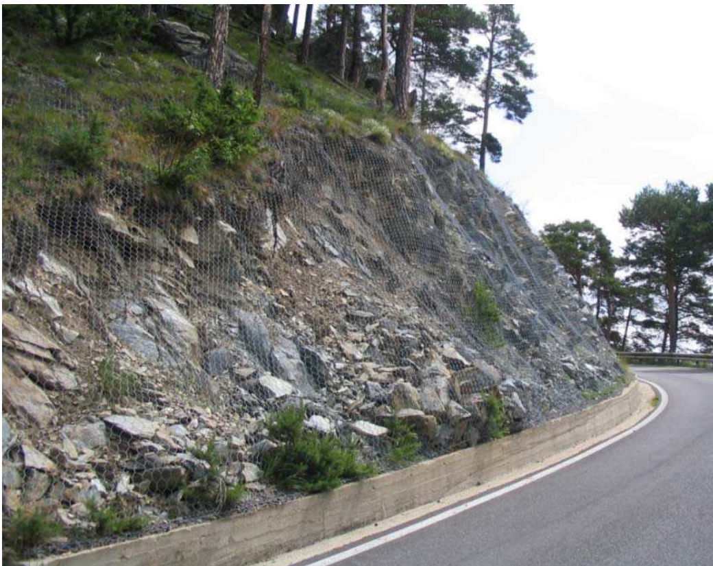
Foto 006 – Opera PENNPR006 . Ripresa da valle dalla SS172 del Colle delle Finestre.
