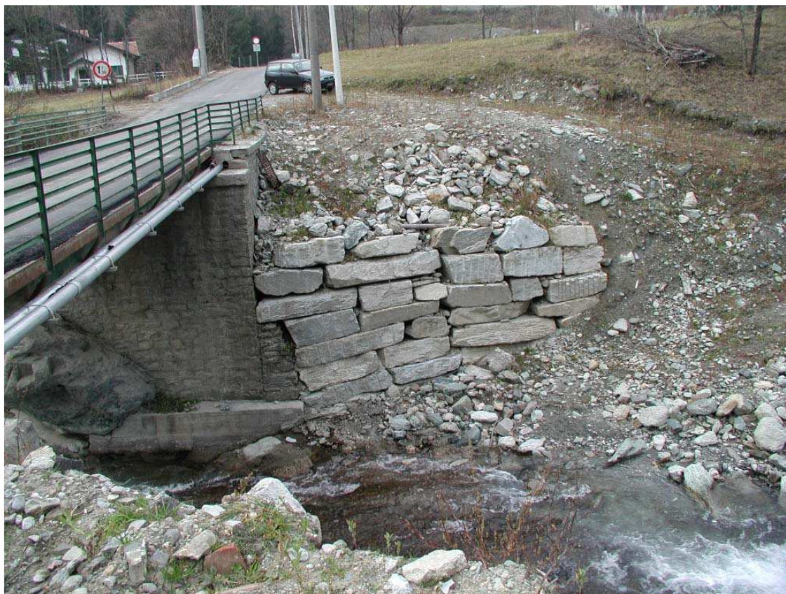
Foto 013 – Opera BATTDS014 . Di fronte, sponda sinistra del T. Chisone.
