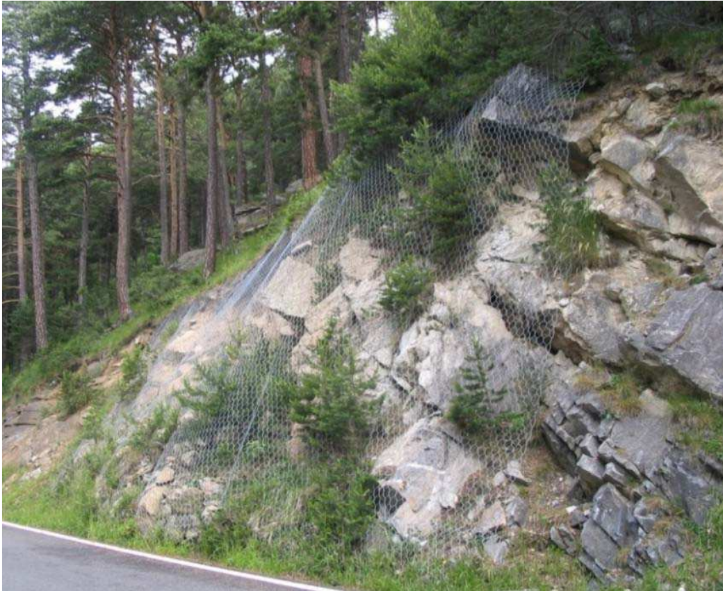
Foto 005 – Opera PENNPR005 . Ripresa da valle dalla SS172 del Colle delle Finestre.
