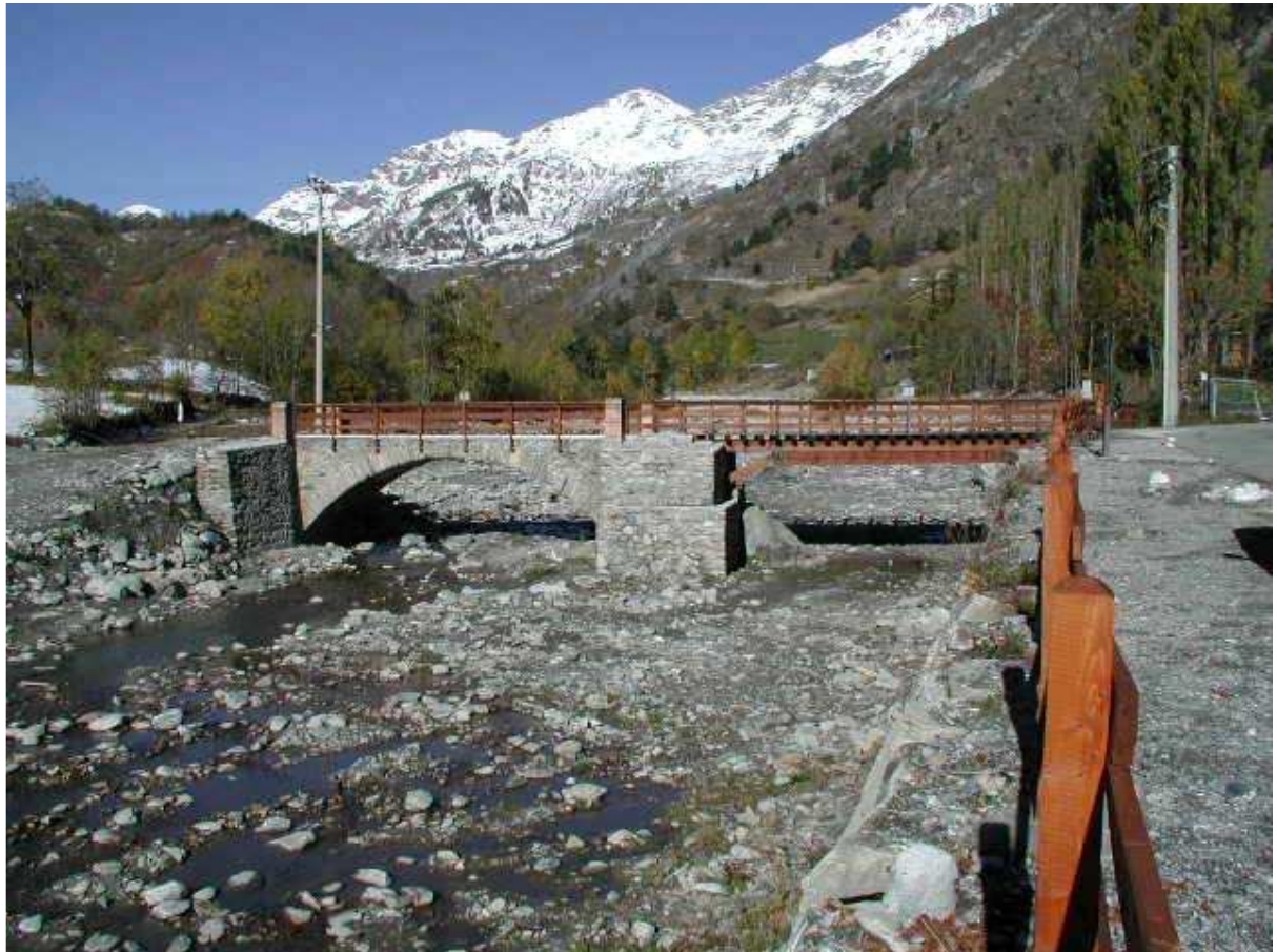
Foto 001 – Opera BATTPO001 . Ripresa da valle. Lavori di ampliamento ultimati.
