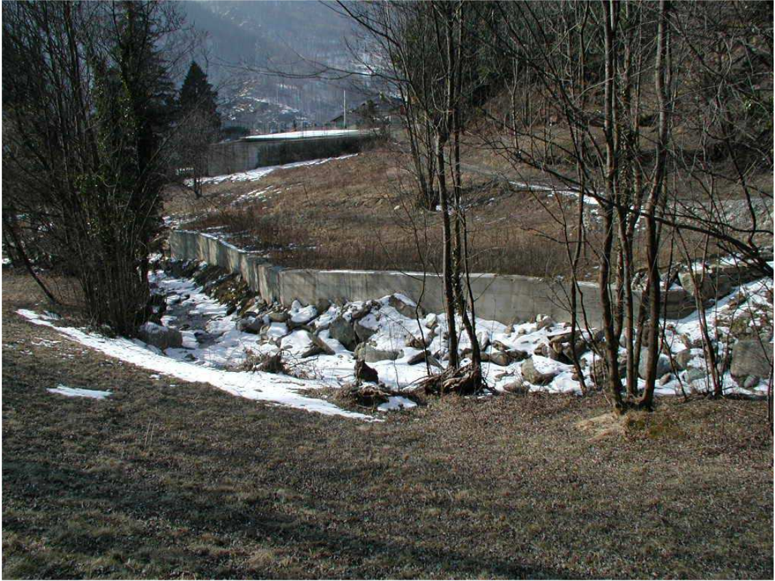
Foto 017 – Opera BELTDS019 . Ripresa di fronte, sponda sinistra del Rio della Draja.
