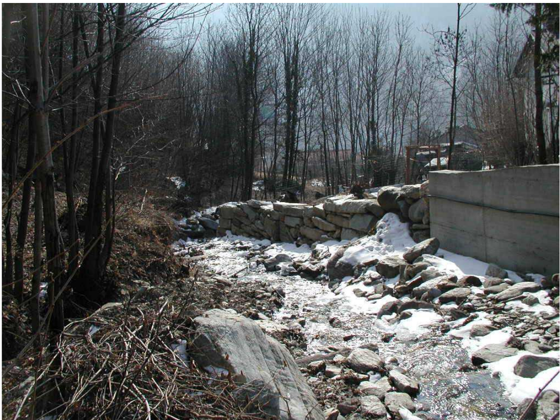
Foto 020 – Opera BATTDS022 . Ripresa da monte, sponda sinistra del Rio della Draja.
