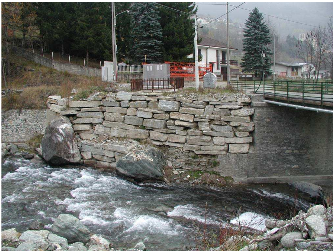
Foto 011 – Opera BATTDS012 . Di fronte, sponda sinistra del T. Chisone.
