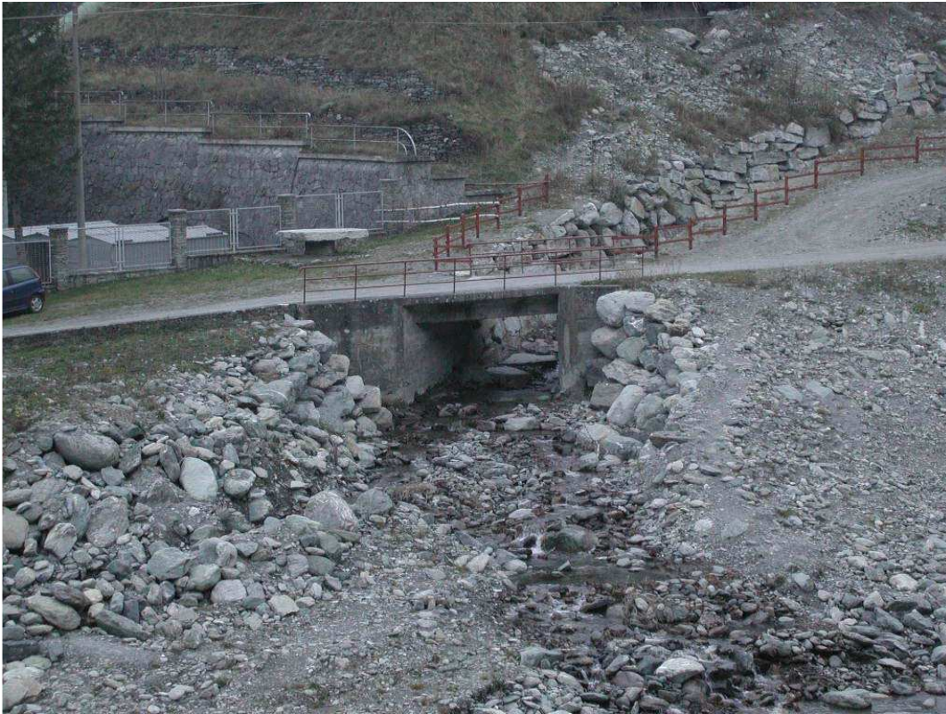
Foto 002 – Opera BELTAG002 . Attraversamento sul Rio di Cristove, ripreso di fronte da sponda sinistra del T. Chisone.
