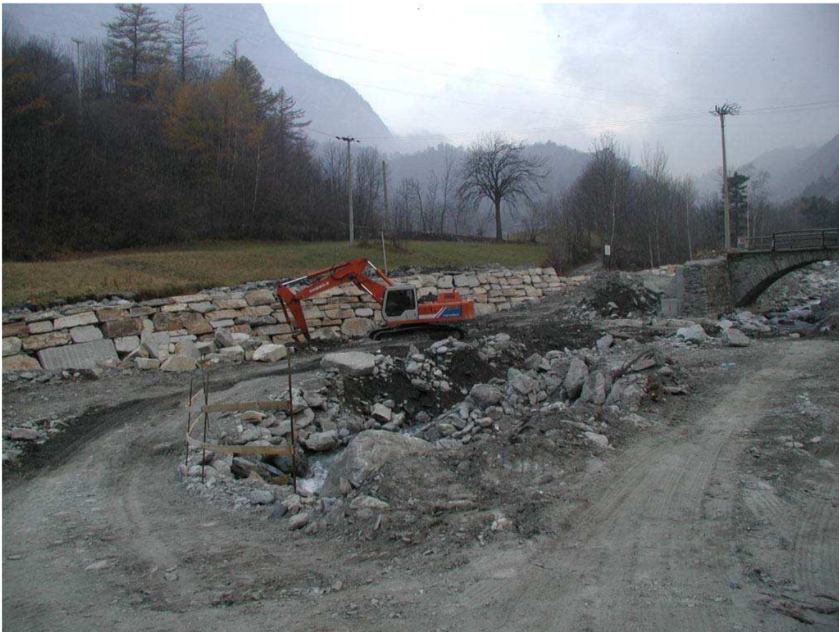
Foto 001 – Opera BATTDS001 . Da valle, in corrispondenza dell'alveo del T. Chisone. Opera in fase di completamento.
