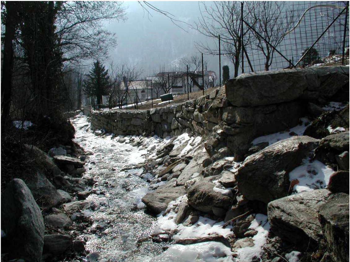
Foto 018 – Opera BATTDS020 . Ripresa da monte, in alveo del Rio della Draja.
