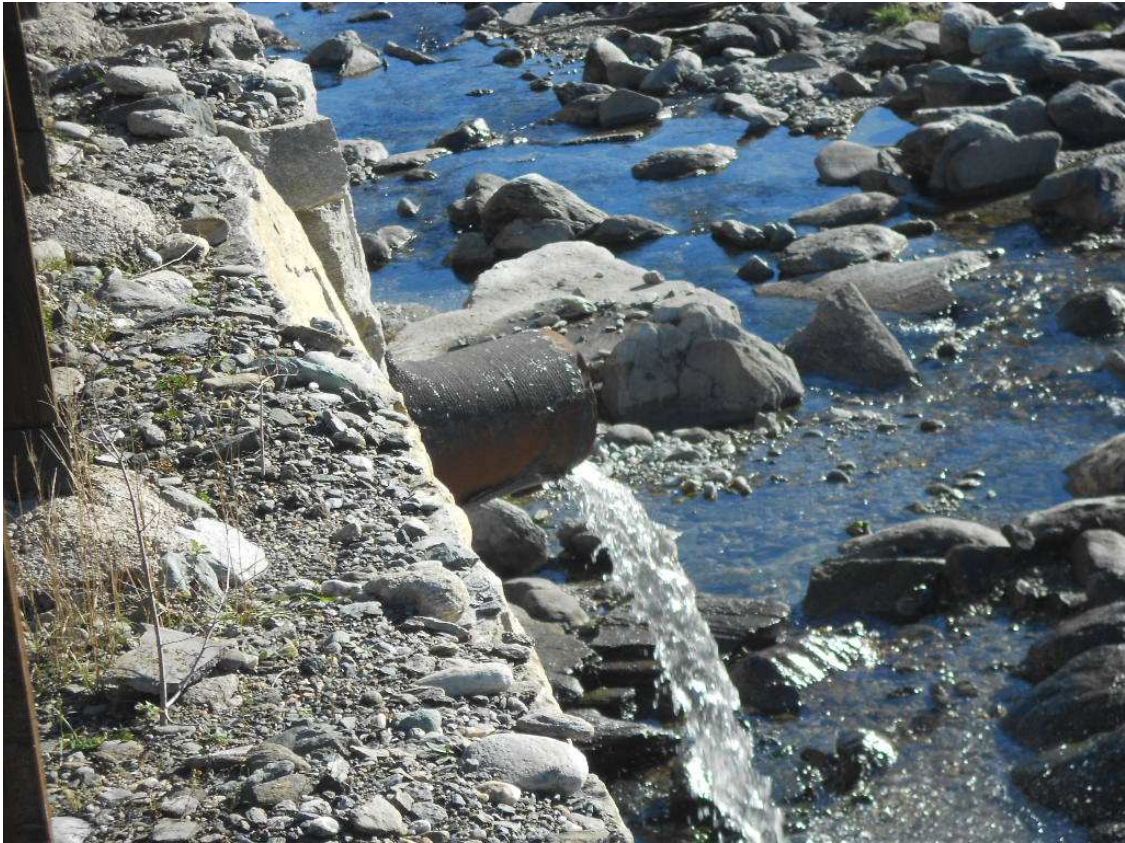
Foto 002 – Opera CASTCA002 . Sbocco della canalizzazione in Chisone.
