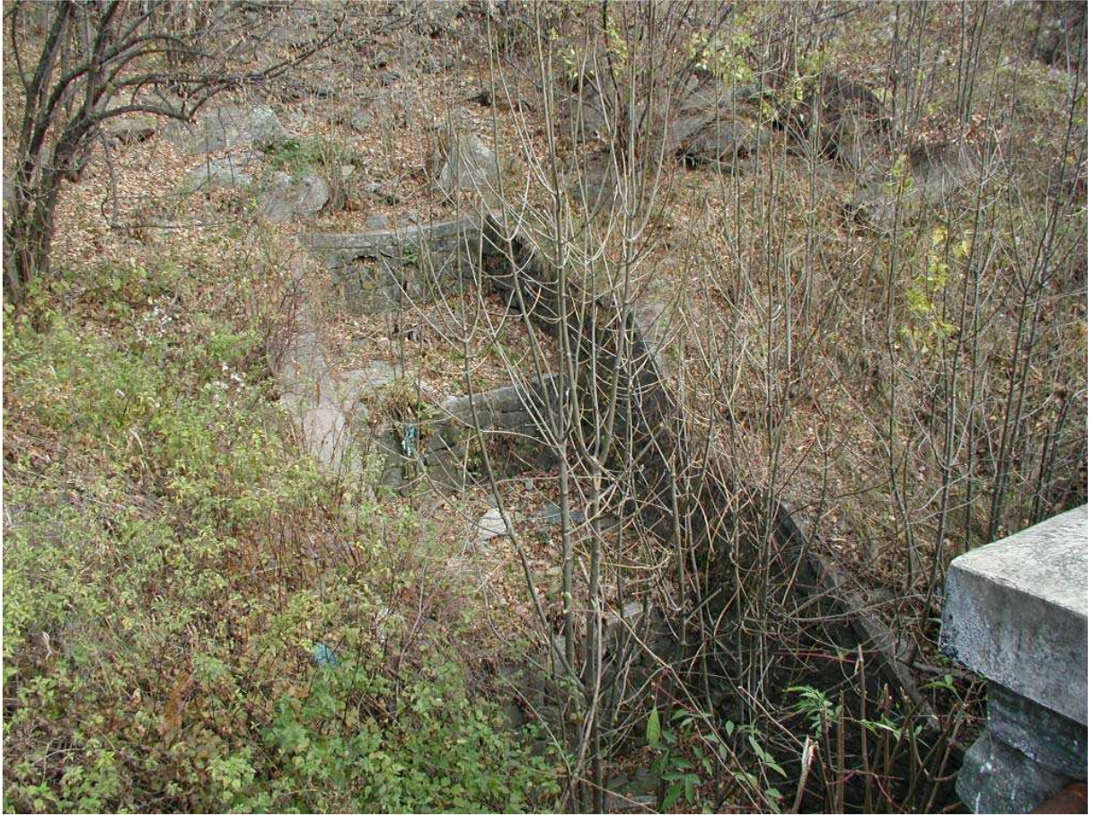
Foto 001 – Opere BATTSO001 , BELTSO002 , BATTSO003 e BELTSO004 , da valle, sponda destra del rio affluente del T. Chisone.
