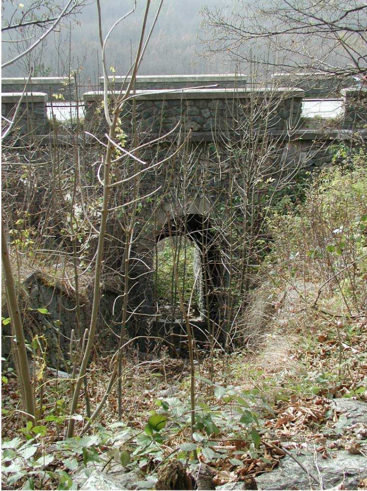
Foto 006 – Opera BELTAG006 . Da monte, sponda sinistra del rio affluente del T. Chisone.
