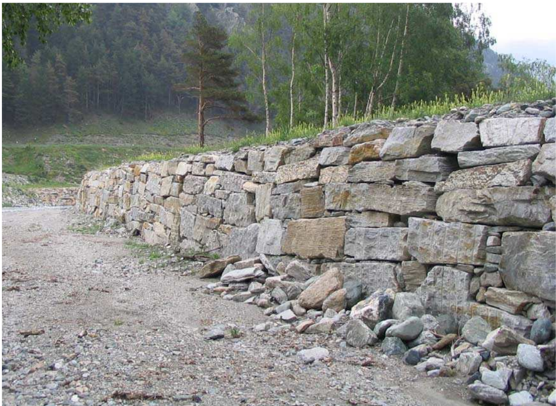
Foto 026 – Opera BATTDS028 . Ripresa da monte, interno alveo Rio delle Verghe. Sostituita da PAIRDS034
