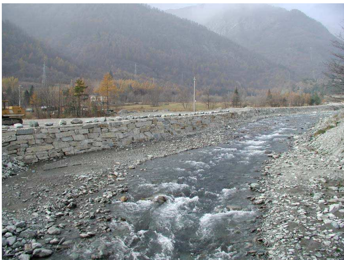
Foto 014 – Opera BELTDS015 . Da valle, in corrispondenza del ponte BELTPO012. Nota: Sostituita da PAIRDS036
