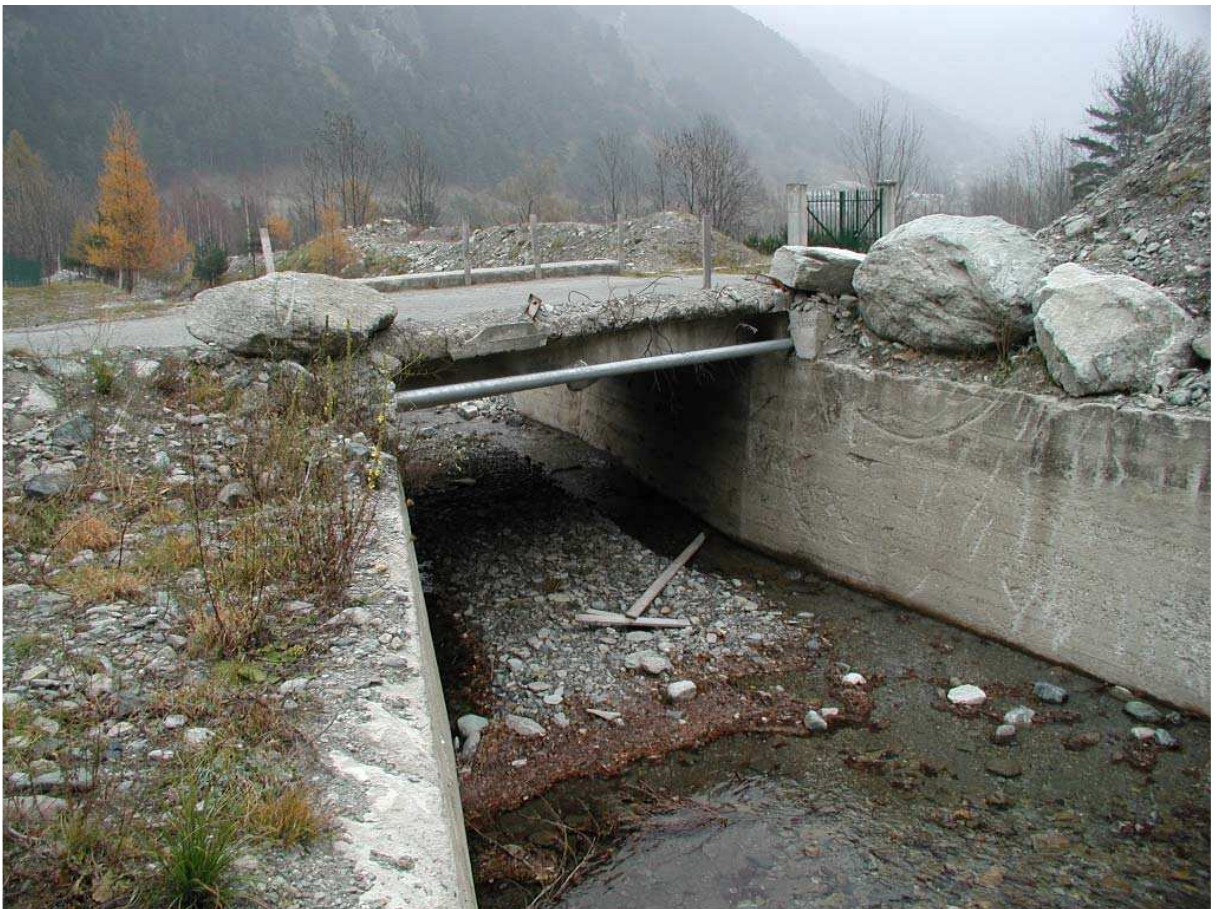
Foto 009 – Opera BATTPO009 . Da monte, sponda sinistra del Rio delle Verghe.
